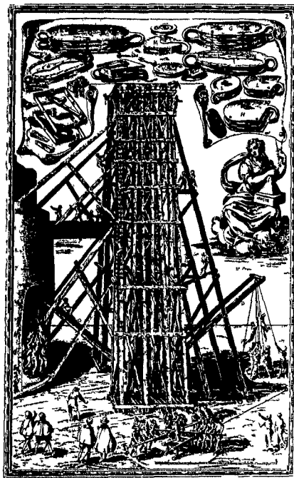
Macchina di Domenico Fontana per trasportare un obelisco
