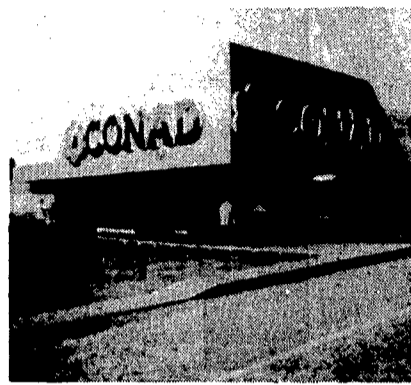
La struttura commerciale di Bologna
