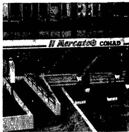
Esterno della nuova struttura Ari di Roma
