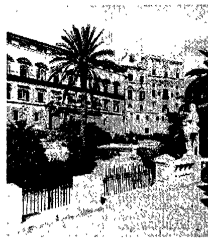
Una veduta del palazzo dei Normanni a Palermo, sede del parlamento regionale
