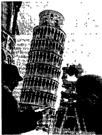
Gli ultimi controlli sulla pendenza della Torre di Pisa
