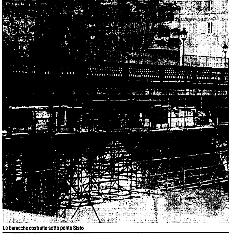
Le baracche costruite sotto ponte Sisto
