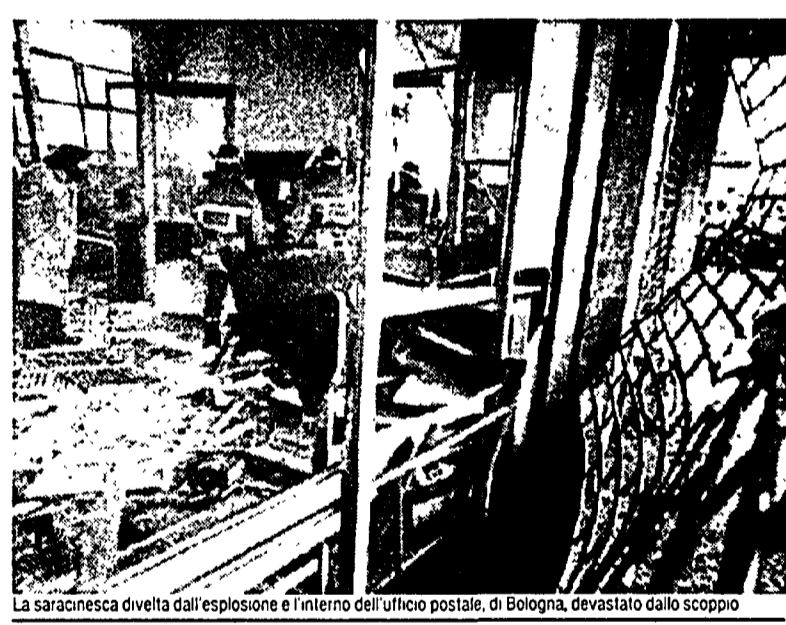
La saracinesca divelta dall'esplosione e l'interno dell'ufficio postale, di Bologna, devastato dallo scoppio
