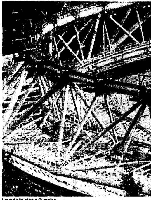
Lavori allo stadio Olimpico
