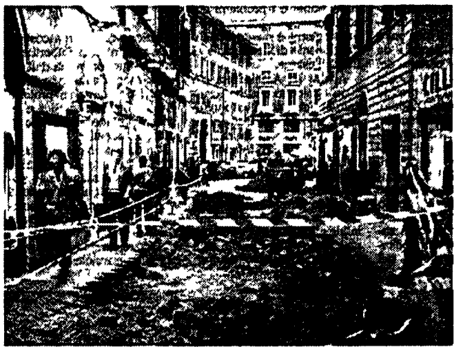
A fianco, sampietrini affari in via delle Carrozze; a sinistra, «crepacchio» all'istituto Damico, qui sotto, piazza Dante bucata dall'Enel, in basso, pescespada al «calcinaccio»
