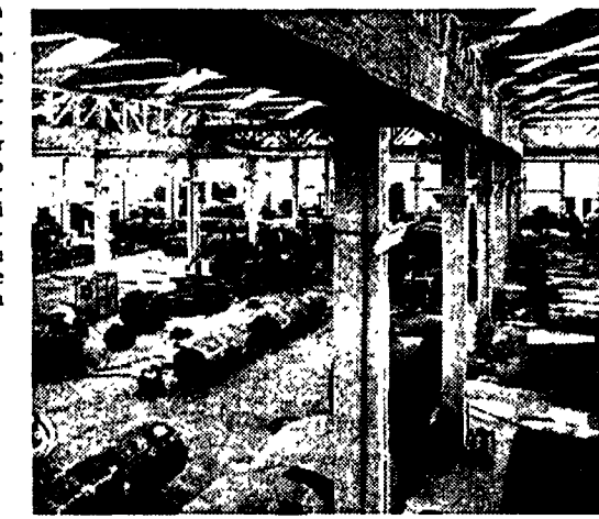
L'interno della Nuovo Pignone a Firenze
