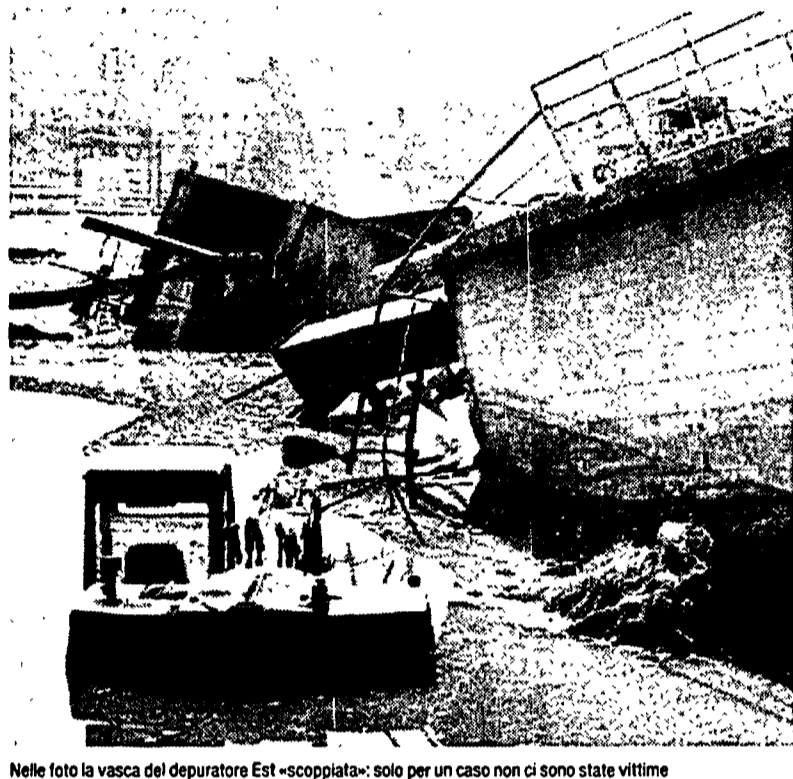
Nelle foto la vasca del depuratore Est «scoppiata»: solo per un caso non ci sono state vittime
