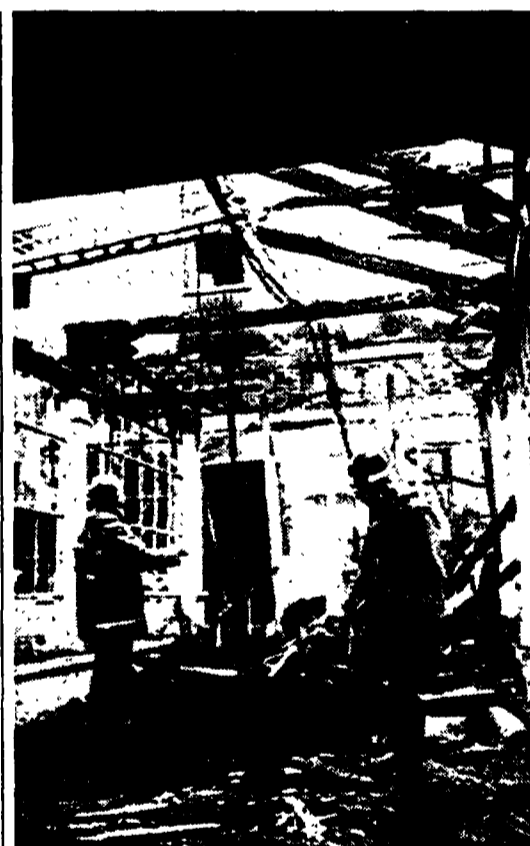
Il reparto del centro dialisi dell'ospedale di Darfo in Valcamonica distrutto dalle fiamme
