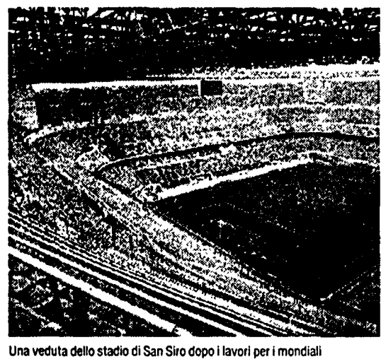
Una veduta dello stadio di San Siro dopo i lavori per i mondiali
