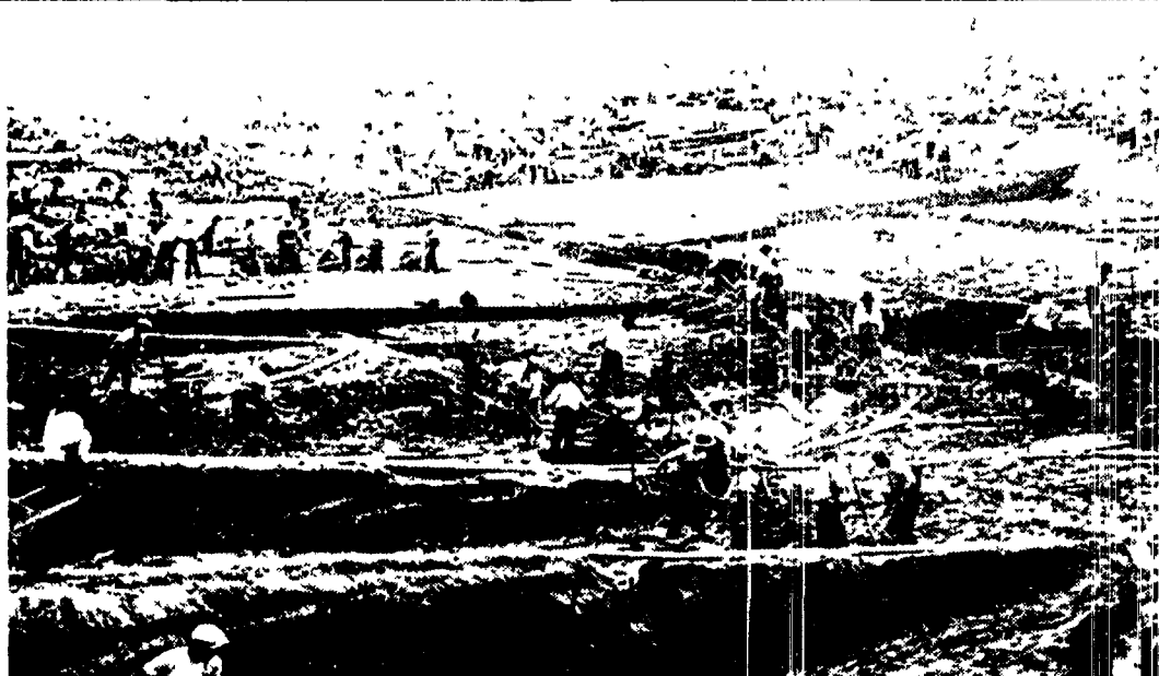
I lavori di costruzione degli argini e dei canali lungo il Secchia segnano la prima grande occasione della Società di Mutuo Soccorso. Le reti di distribuzione metano e acqua (nella foto in basso la posa dei tubi) sono il fiore all'occhiello della moderna Cpl.
