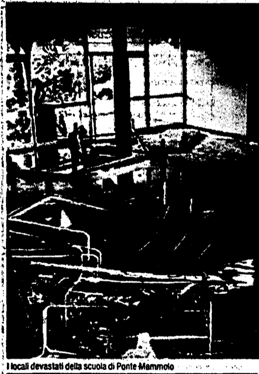
I locali devastati della scuola di Ponte Mammolo
