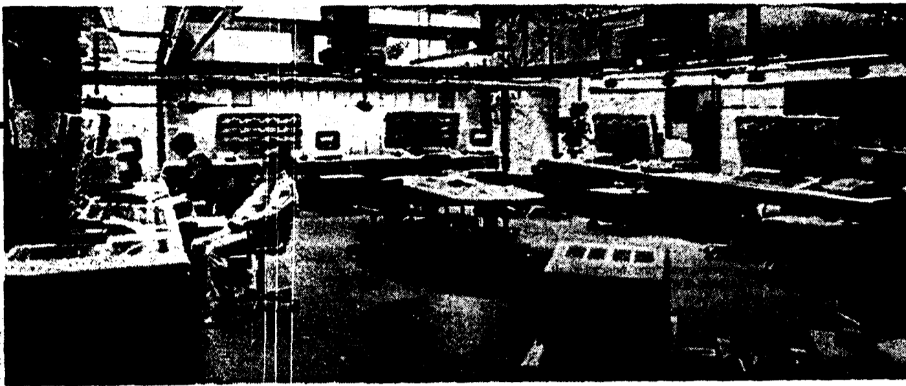
La sala con gli impianti tecnici della Rai a via Asiago, Roma. Nella foto qui sotto, il Telegioco
