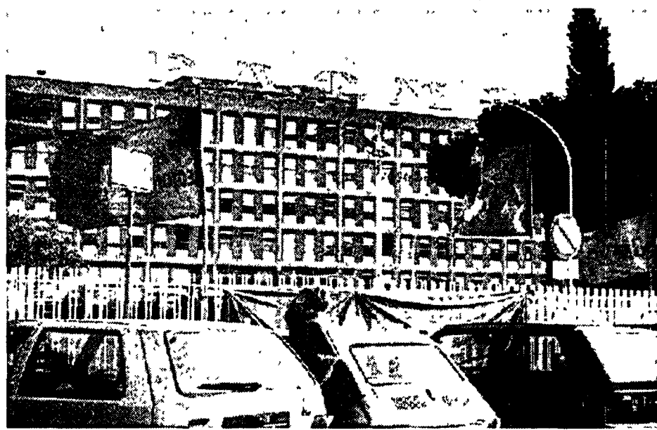
L'ingresso della Fatme, che produce centraline telefoniche elettroniche. In basso, un'operaia al lavoro in fabbrica
