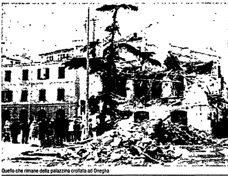
Quello che rimane della palazzina crollata ad Oneglia
