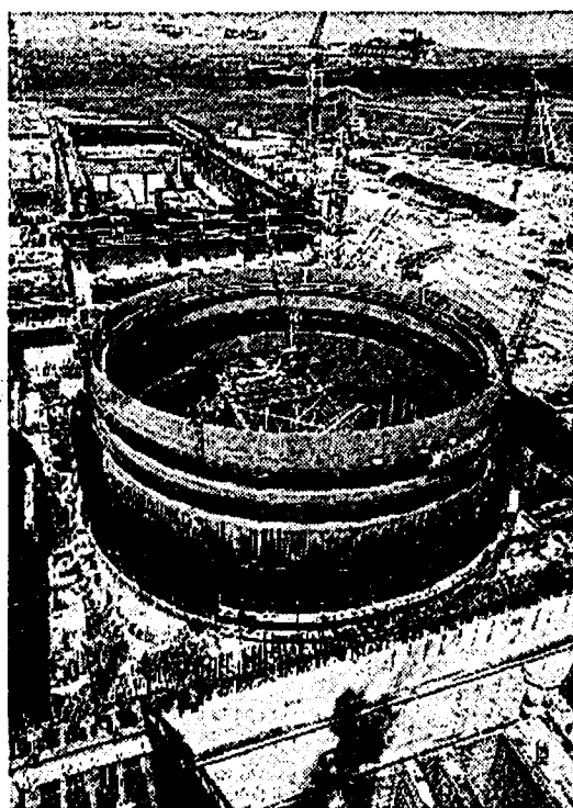
A sinistra, il cantiere della centrale di Montalto. Sopra, il vecchio reattore nucleare
