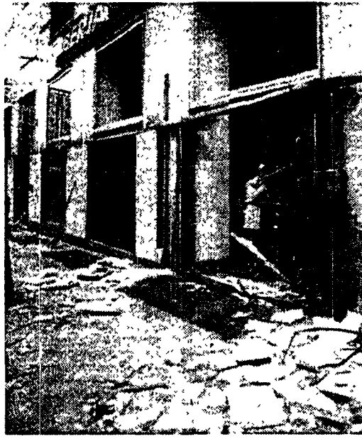
Gli uffici dell'ambasciata a Milano danneggiati dall'esplosione
