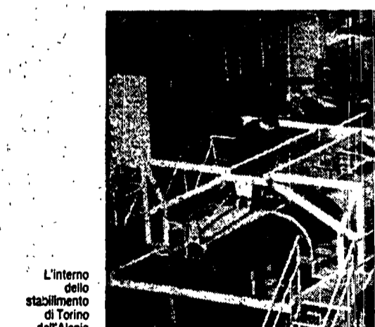
L'interno dello stabilimento di Torino dell'Alenia
