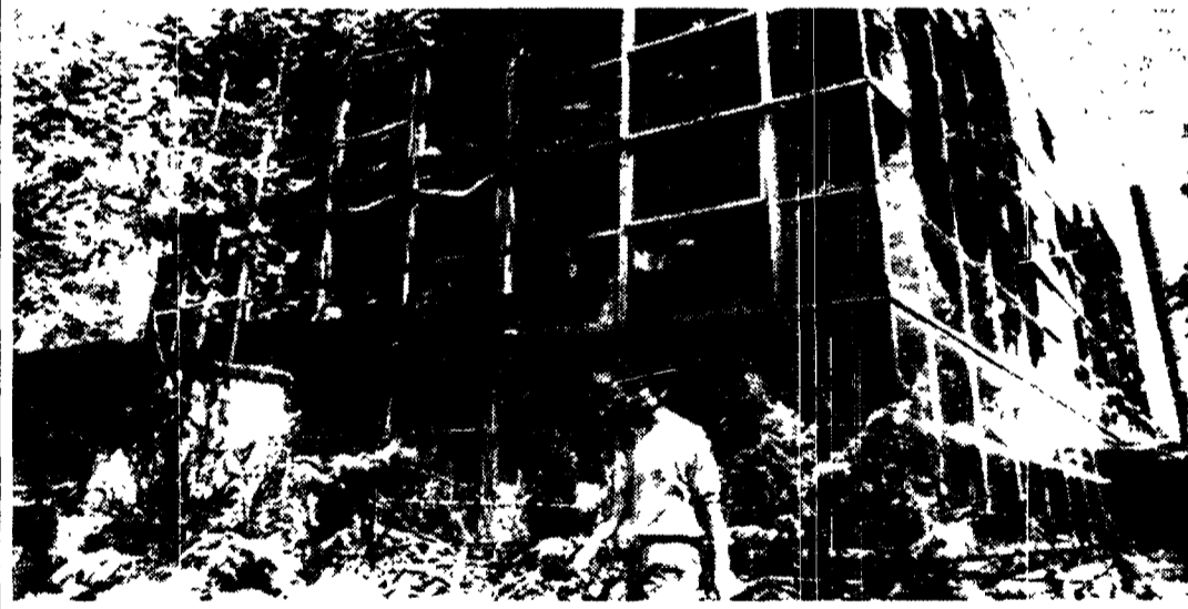
Gli uffici distrutti dall'incendio dell'ex ceramica Campanella, dove avevano trovato alloggio abusivamente centoventi extracomunitari
