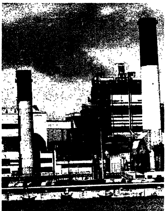
La centrale di Fiumaretta
