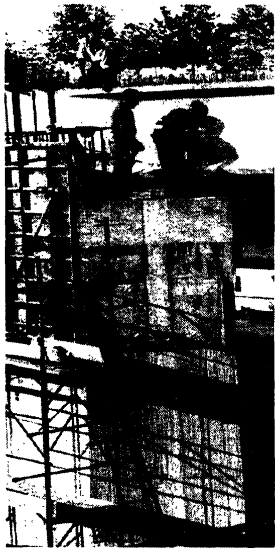
Cantieri edili. L'Associazione costruttori: «Ci condannano ai subappalti»
