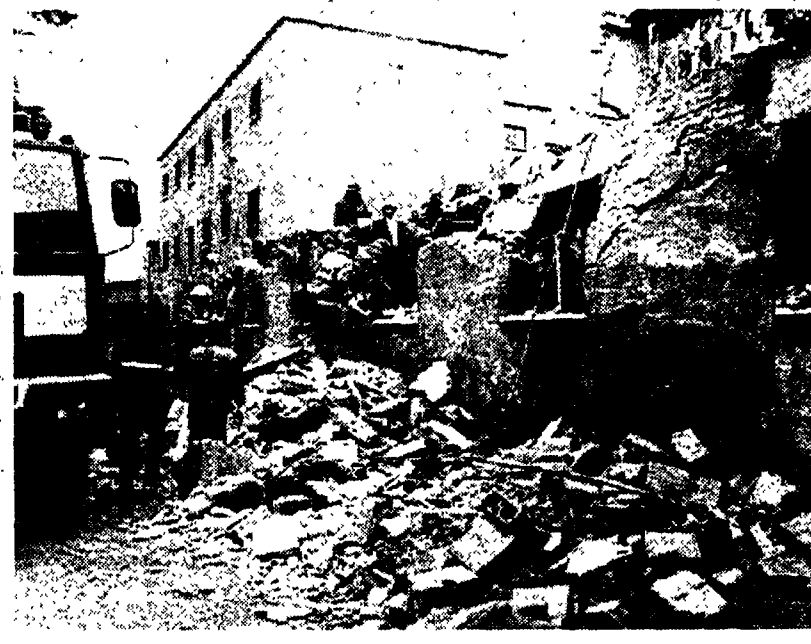
Il crollo di un edificio della Scuola dei vigili del fuoco che ha causato la morte di tre operai
