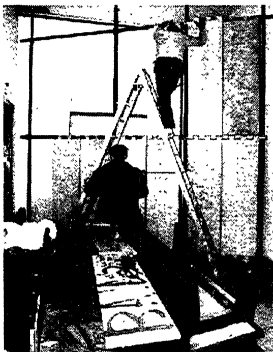
Operai al lavoro per «murare» l'aula 6 di Lettere
