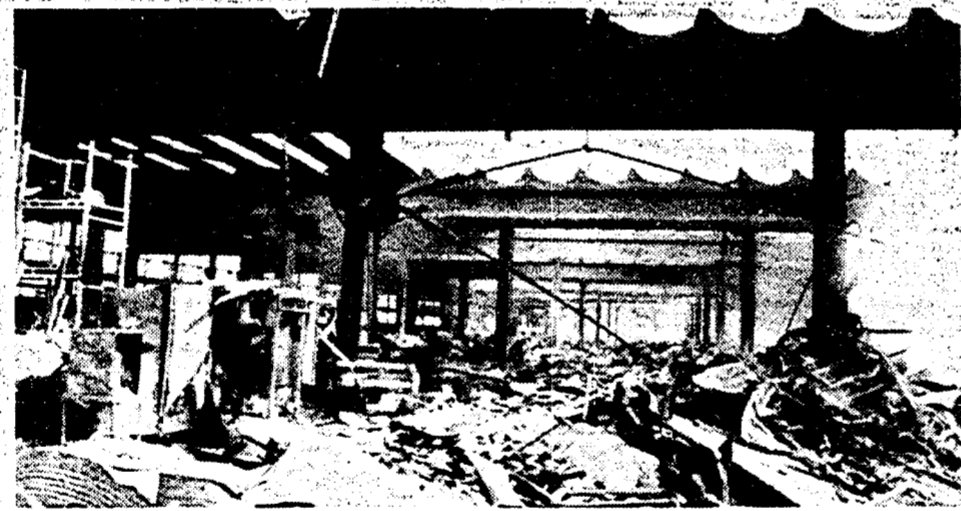
L'interno del capannone dello stabilimento Merloni distrutto dall'incendio
