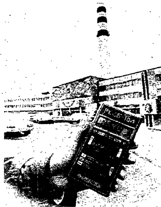
Un rilevamento di radioattività alla centrale nucleare di Petersburg
