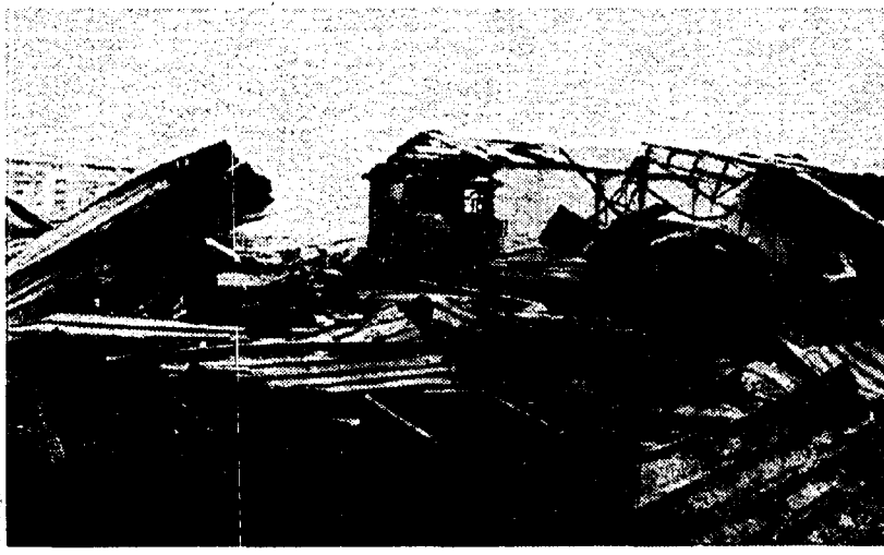
I capannoni distrutti dall'incendio negli stabilimenti di Cinecittà a Roma
