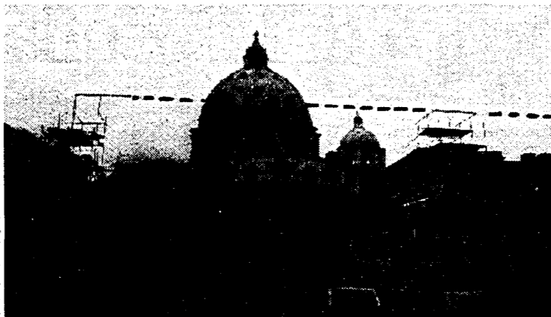
La linea tratteggiata indica l'altezza finale dell'edificio in costruzione
