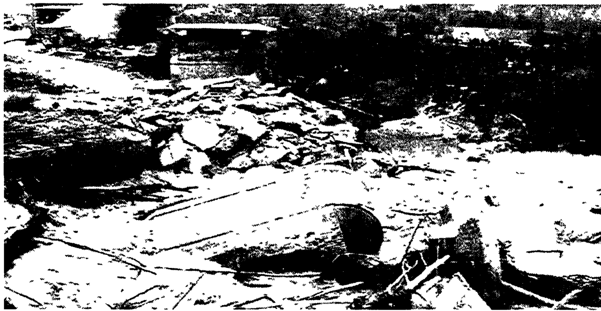
Il ponte in località Moscufo crollato per la piena del fiume Tavo. Sotto al titolo: l'intervento dei mezzi anfibici al sottopasso sulla A 14 a S. Benedetto del Tronto. A fianco al titolo: lo straripamento del Pescara. In basso: il porto canale di Pescara con i pescherecci travolti dalla furia delle acque.
