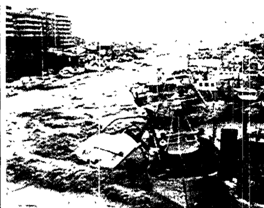
I danni provocati dalla piena nel porto canale di Pescara
