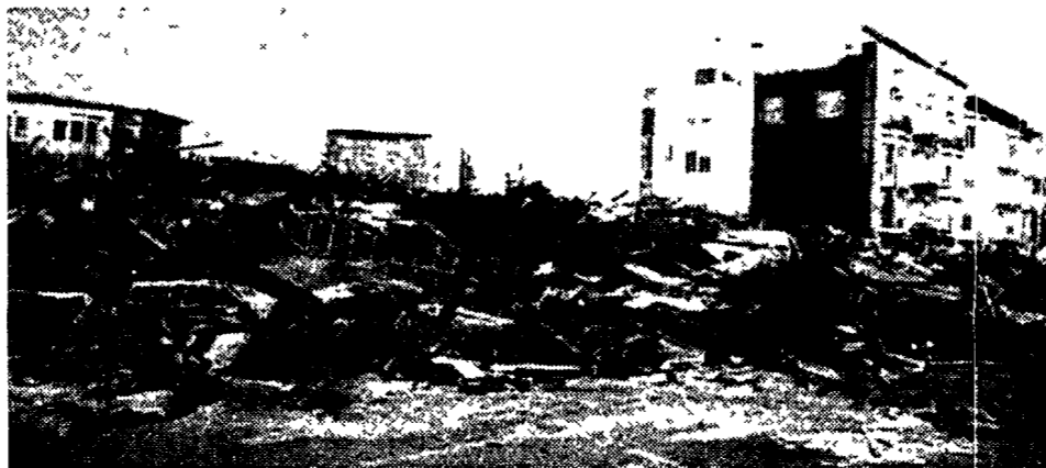
Edifici distrutti a San Francisco in seguito al terremoto del 1989
