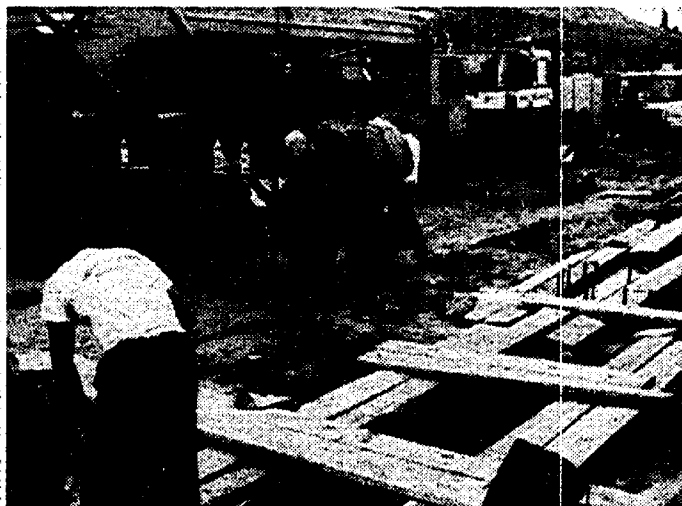
L'incidente mortale nel cantiere della «Toto spa», in via Flaminia, nel quale ha perso la vita Lino Frazzini
