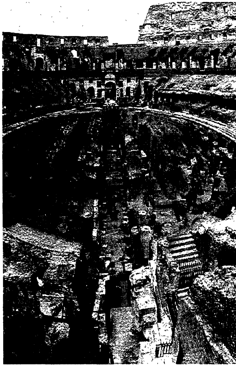
L'interno del Colosseo. Il monumento è in gravissime condizioni causa l'inquinamento e il traffico
