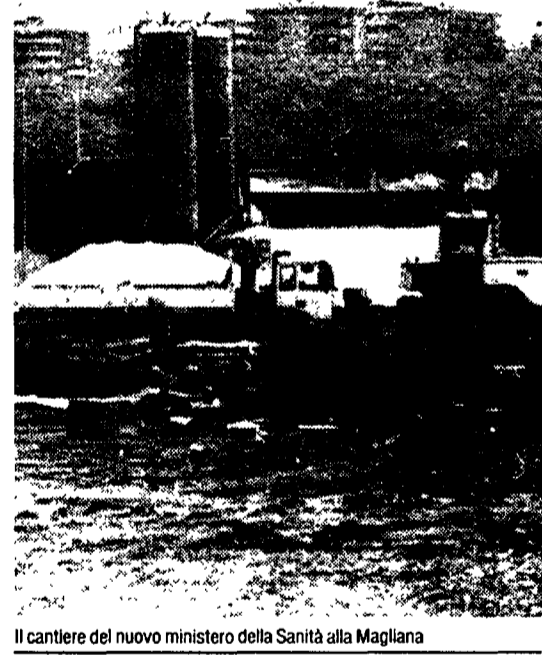
Il cantiere del nuovo ministero della Sanità alla Magliana
