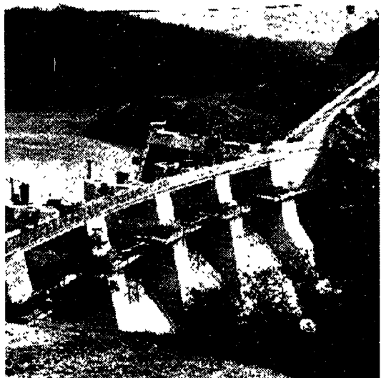
I lavori di costruzione di una diga in Toscana
