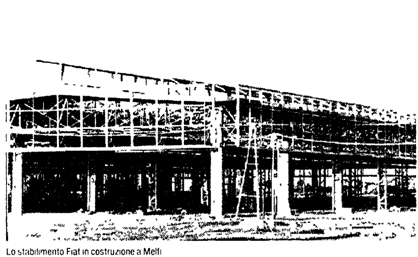
Lo stabilimento Fiat in costruzione a Melfi
