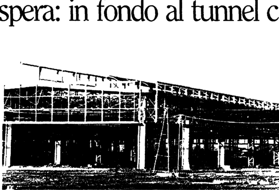
Lo stabilimento della Fiat in costruzione a Melfi
