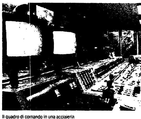
Il quadro di comando in una acciaieria
