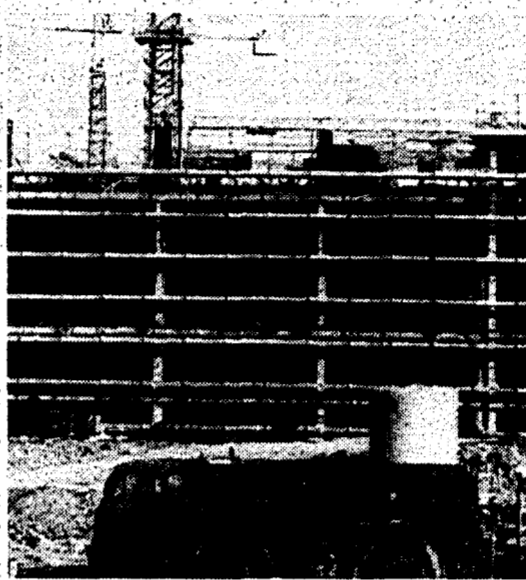
Il cantiere del ministero della Sanità
