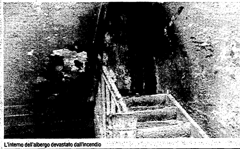
L'interno dell'albergo devastato dall'incendio
