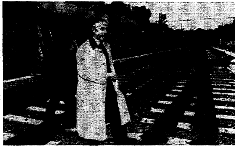
Il sopralluogo di magistrato e polizia nella stazione inutilizzata di Vigna Clara
