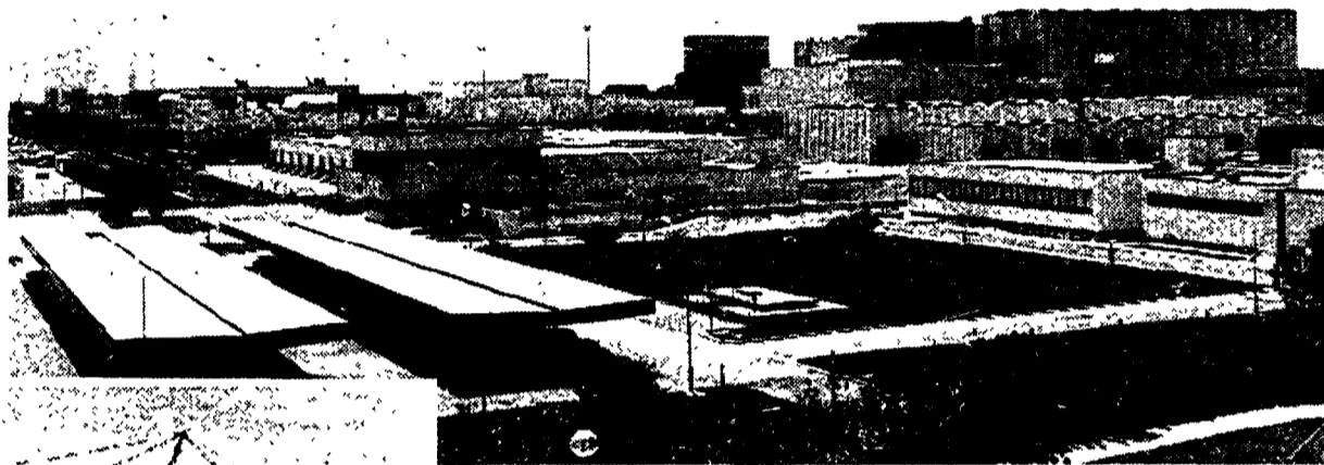
La centrale, ex nucleare, di Montalto di Castro
