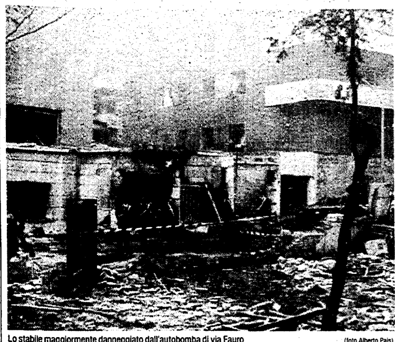
Lo stabile maggiormente danneggiato dall'autobomba di via Fauro
