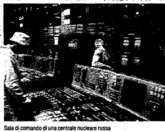
Sala di comando di una centrale nucleare russa
