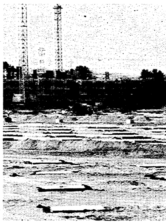
L'area di Ponte Galeria dove è in costruzione l'autoporto; sopra il prospetto della prevista e contestata realizzazione
