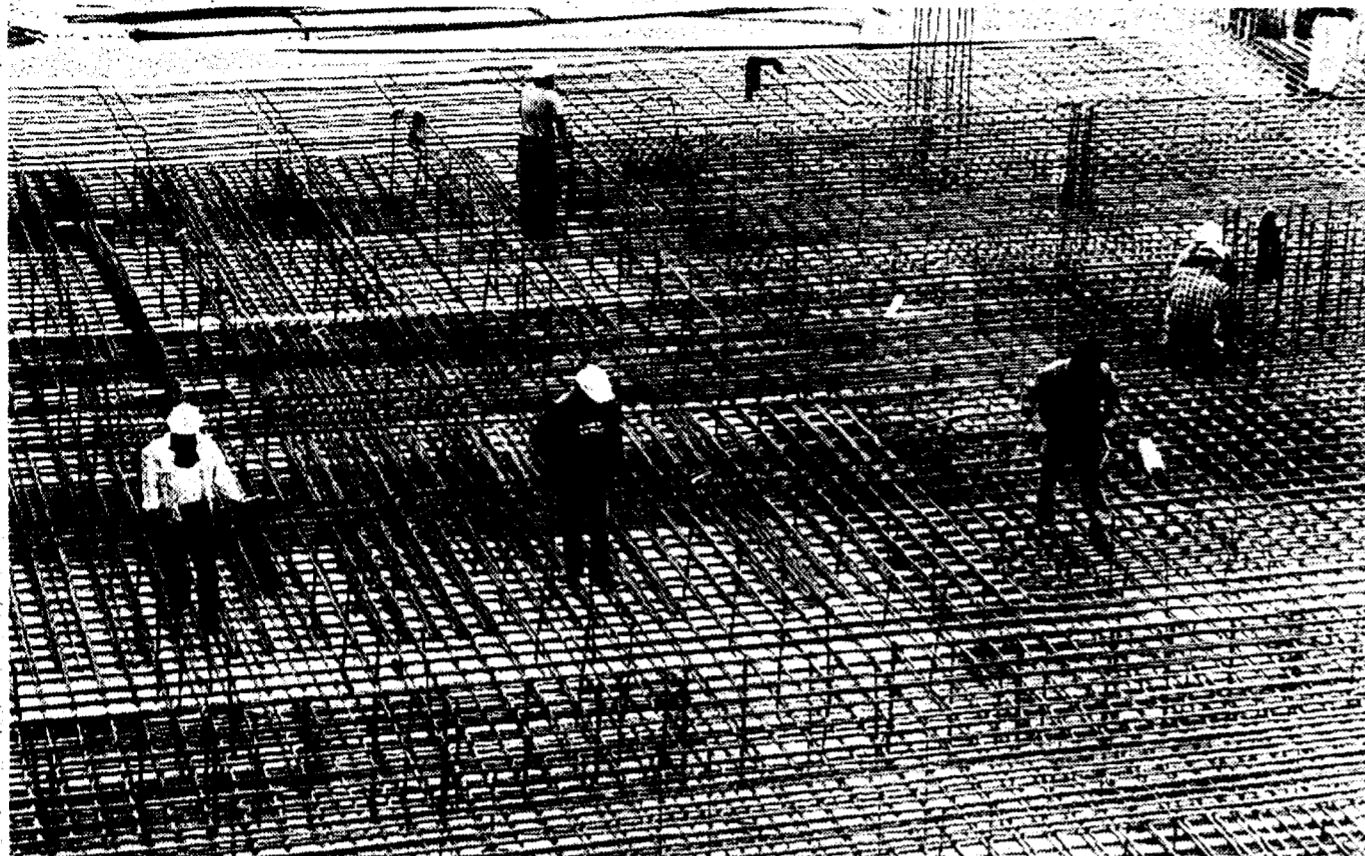
Edili ai lavoro in un cantiere sulla Flaminia
