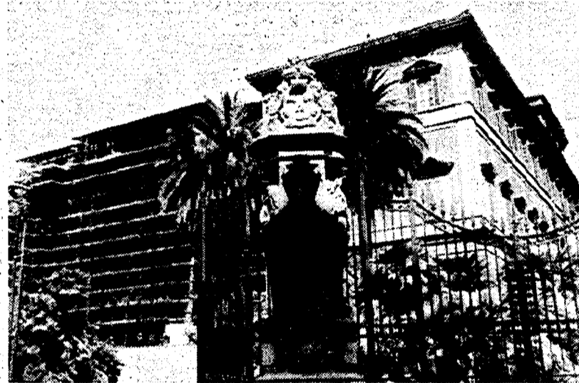
La facciata di palazzo Barberini con le impalcature per lavori in corso
