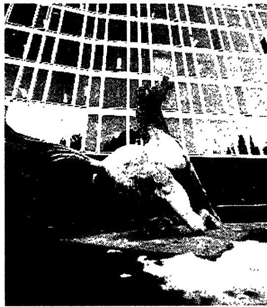
La sede Rai di viale Mazzini
